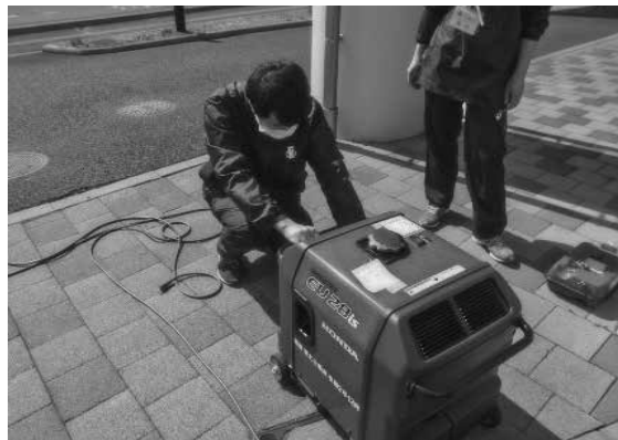
自家発電機作動訓練
